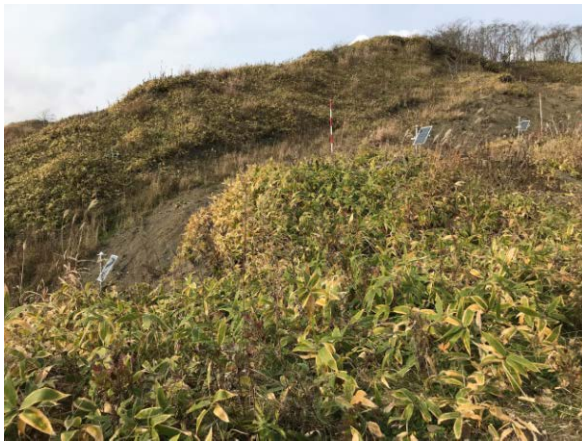
図1 GNSSによる地すべりの 同時多点観測（平成30年）
