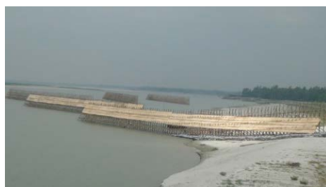
バングラデシュ国のジャムナ川に設置したバンダル型水制（カジプール地点）
