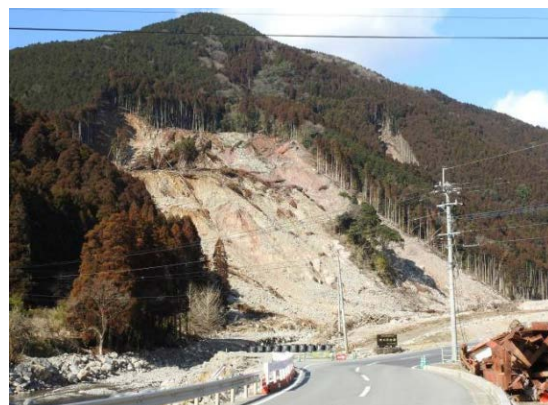
小野地区の深層崩壊
