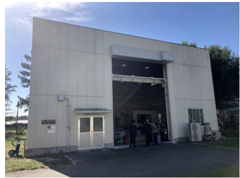
遠心力载荷実験室
