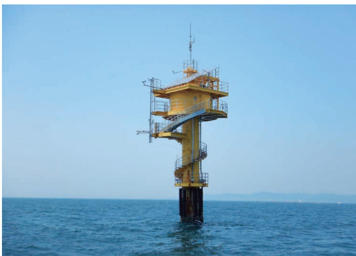
白浜海象観測所高潮観測塔
