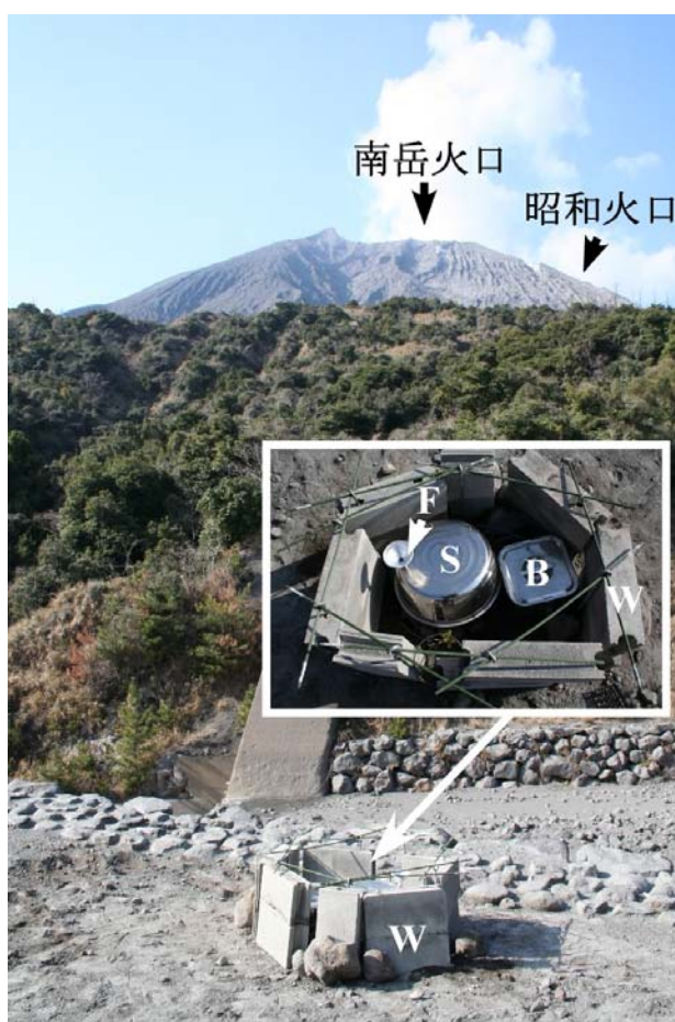
図 7. 桜島南西有村川における自動火山灰採取装置の設置状況。F:採取口, S:試料保管部, B:電源部, W:防風壁。
