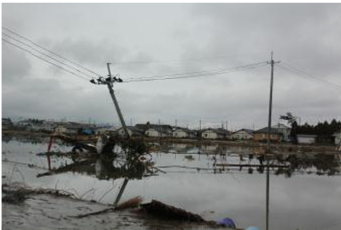
漂流物によって折れた電柱
