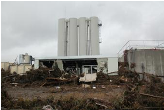
津波によって破壊され膨大な 土砂埋もれる工場
