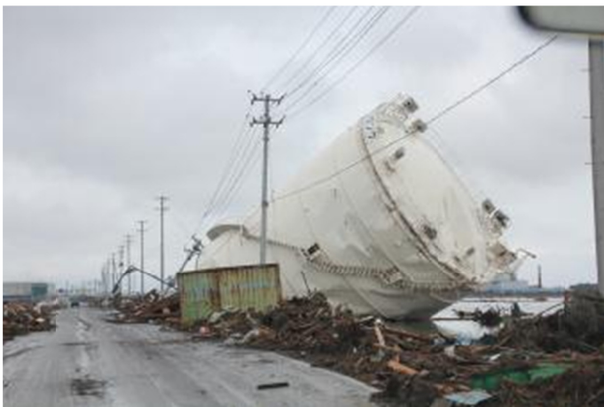
津波によって海岸部より 1 km 以上流されたと考えられるタ ンク
