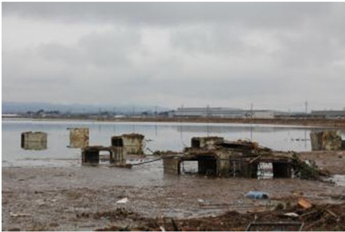
津波によって流された構造物 の残骸
