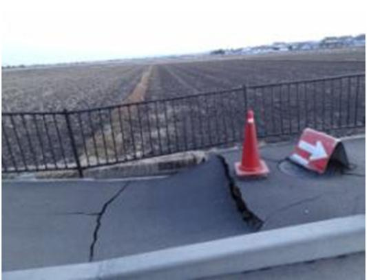
各所で路面が陥没したり、マンホールが浮き上がり、橋の部分で段差が発生している。
