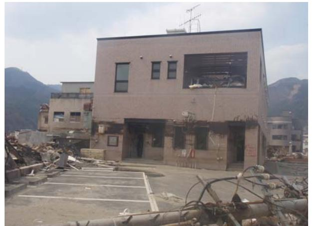
図5 大船渡の建物（1階外壁部分に黒く石油の付着痕が残っている）
