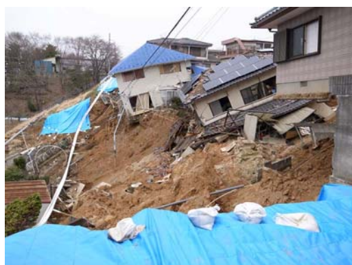
写真-5 あさひ台地すべり崩壊域の頭部
