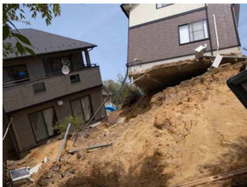
写真-9 西花苑地すべりの頭部滑落崖。 基岩は細粒砂岩
