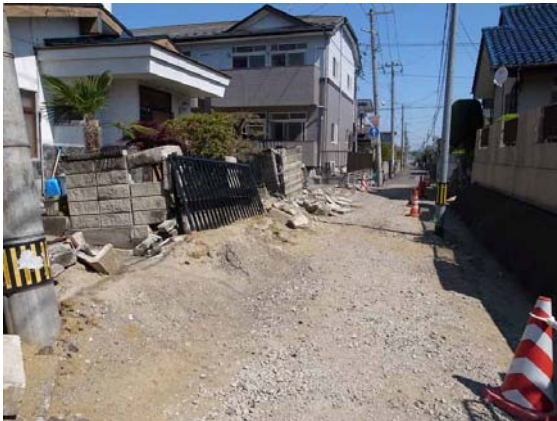
写真-7 顕著な隆起域(道路面は復旧の際の掘削によって下げられた)
