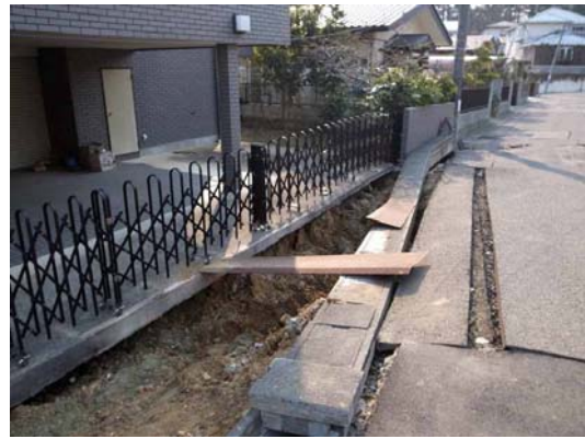
写真-2 頭部～側部の引張亀裂
