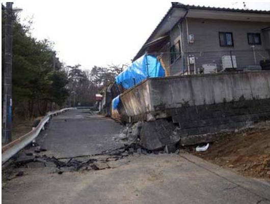
写真-1 末端部の圧縮変形
