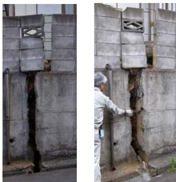
写真-3 頭部の亀裂.左 3/27 右 5/10
