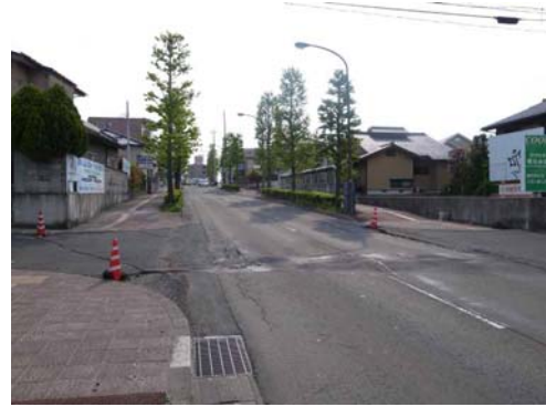
写真-8 浅いすべりの末端(コーンが置かれている場所).奥から手前に向かって滑っている
