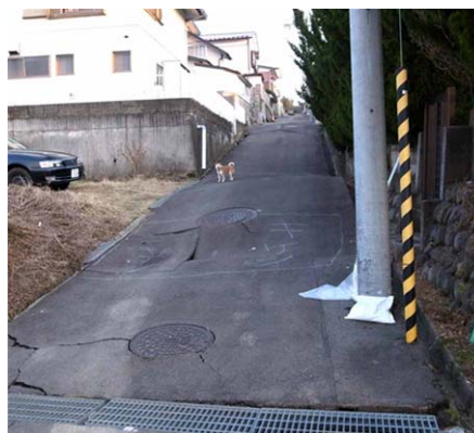
写真-4 末端の隆起と傾動
