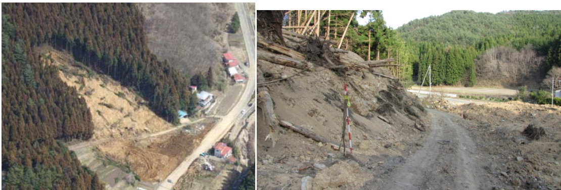
岡ノ内の崩壊。左：空中写真（国土交通省撮影，3月14日）。右：崩壊下部道路脇の法面の半分程度の高さまでは発生前の地山。
