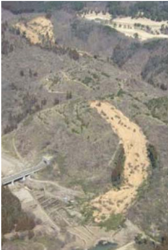
白沢地区の崩壊全景（国土交通省撮影，3月14日）
