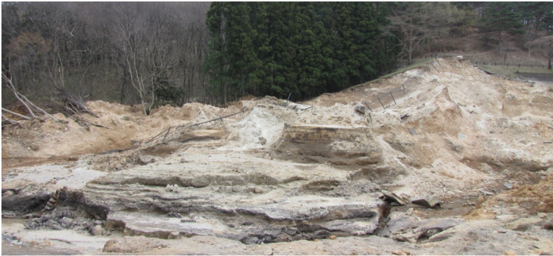
藤沼ダム右岸側堤体のスランプ。次のスケッチを参照。
