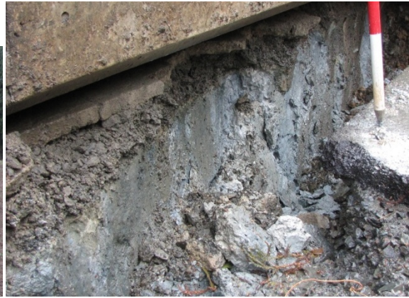
地震断層の下に認められた断層ガウジ
