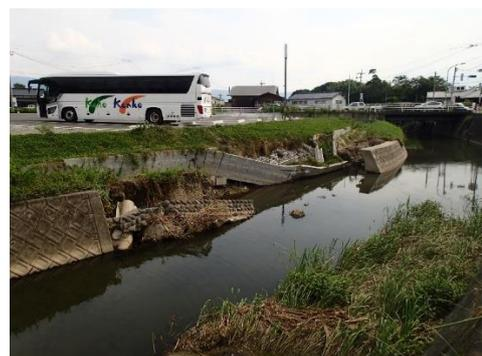
図-2 新立川上流部の護岸の被災
