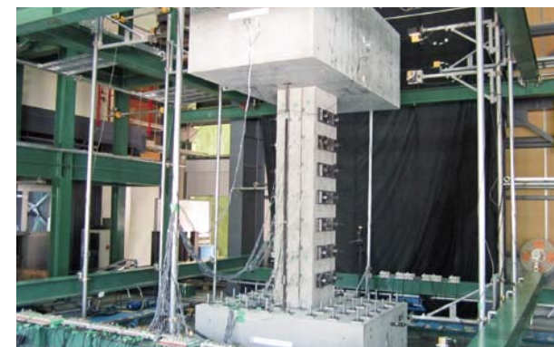
摩擦減衰機構を有する集合RC柱の振動台実験 Shaking table test for a RC column installing an advanced system
