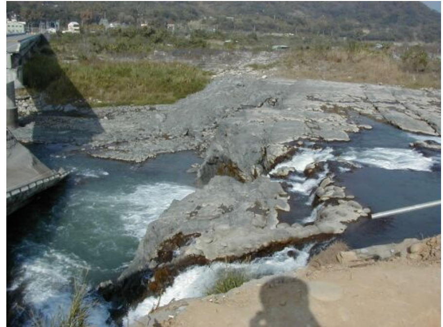
1999年台湾・集集地震 地表地震断層（逆断層）に よって淹ができた
