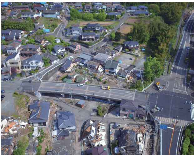
図1 熊本地震時の益城町の被害の様子。ほとんどの建物が倒壊していることがわかる。
