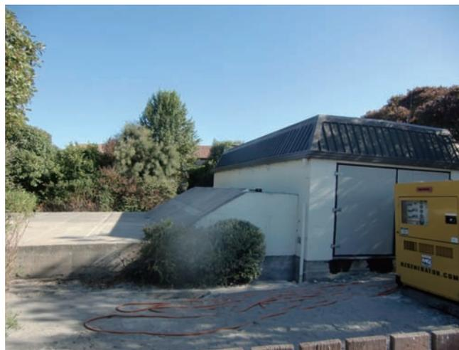
写真4 液状化によって浮き上がりが生じた
