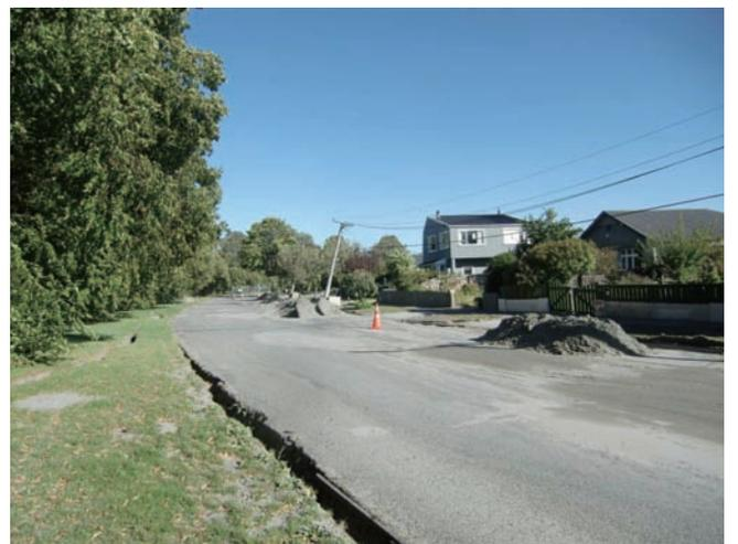
写真1 液状化によって傾いた電柱、噴出した砂の山、側方流動による開口亀裂
