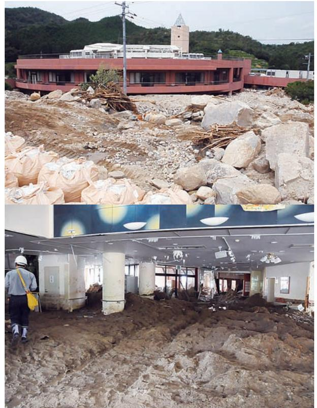
写真-1 上：上流側から見たライフケア高砂山側に面した1階部分は土砂で埋まっていた
