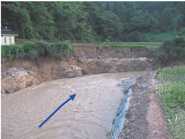
写真1 蛇行部外岸側の側岸侵食
