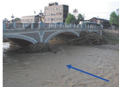
写真2 浅野川大橋にかかった流木
