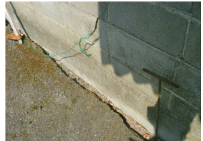
写真6 工場外壁の地面
