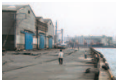
写真6 液状化に伴う岸壁の損傷 (福岡市沖浜町)
