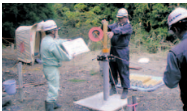
図4 爆薬の装填、30～50mの孔中に100～700kgのダイナマイトがセットされた。
