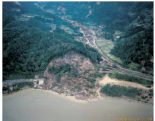
写真1 白岩の崩壊現場（撮影：㈱八州）
