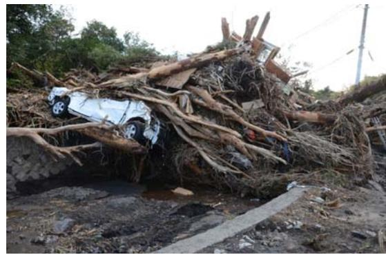
水路にかかる簡易橋にひっかかった流木と自動車。土砂流がこれにより溢れ、左右の下流側の家屋が破壊された。
