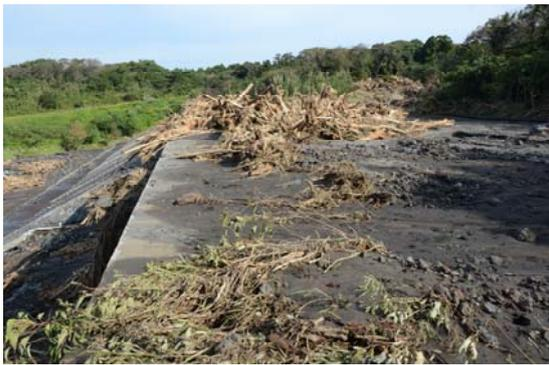
砂防ダムのスリットに捉えられた流木と満砂状態のダム。
