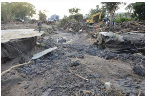
橋から溢れた土砂流の通過跡。家屋は流出し基礎だけが残った。周囲の地盤は2 m程度浸食を受けている。
