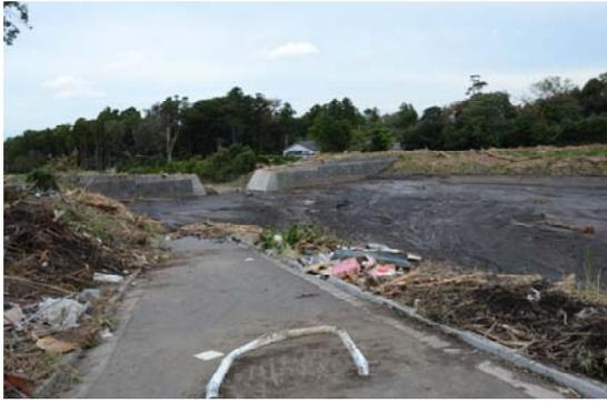
崩壊が集中した斜面から二手にわかれた谷の合流点にある遊砂池。満砂状態になった。
