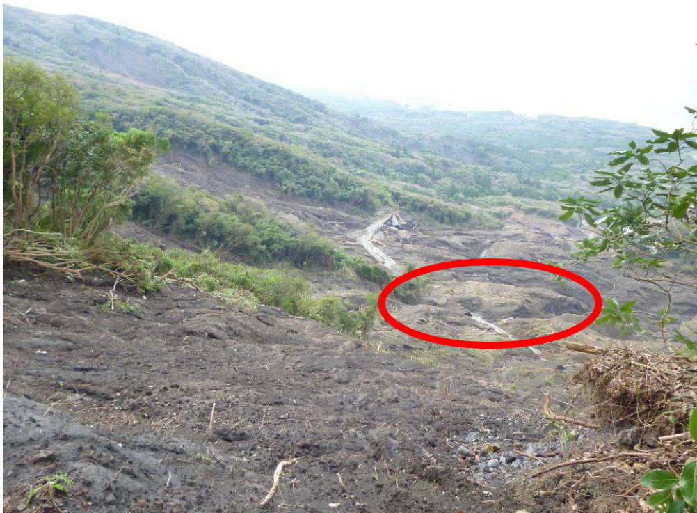
写真4：御神火スカイラインより下方の斜面崩壊。赤丸で囲ったところなどに崩落していない不安定な土砂が見られる。
