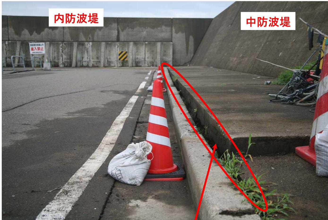
物揚場が35cm程度沈下, 5cmの隙間
