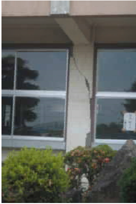
写真1 RC造柱のせん断破壊 (大崎市立上野目小学校)
