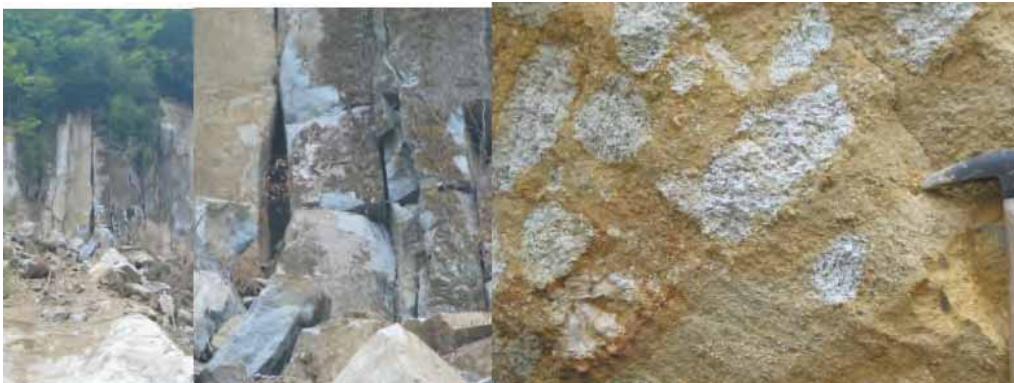
写真-4 行者の滝南方の崩壊。溶結凝灰岩の破壊（左、中央）と軽石（右）。 節理に囲まれた柱の脚部が足を投げ出すようにして破壊。中央は左の写真中央部の拡大。
