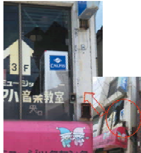
写真6 窓ガラスの破損・落下被害 (大崎市七日町)
