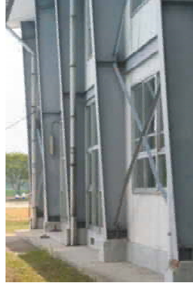
写真2 体育館のブレース座屈 (栗原市立一迫中学校)
