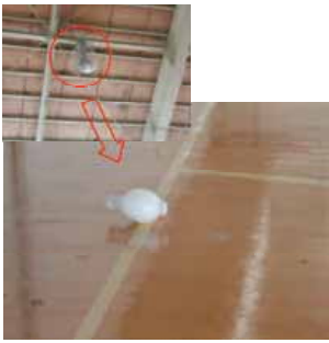
写真5 体育館の照明落下 (栗原市築館体育センター)
