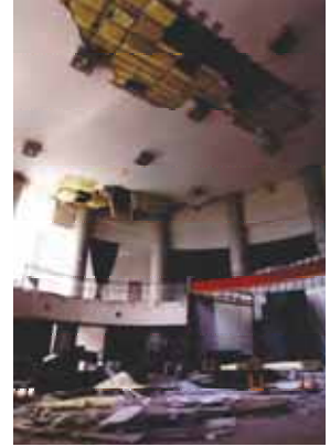
写真4 天井材の落下被害 (ハイルザーム栗駒) 5)
