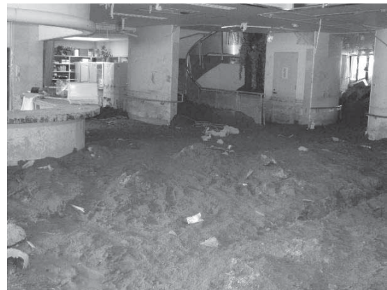
写真-5 老人ホーム内の土砂堆積
