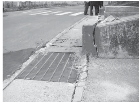
写真-4 敷地西側の擁壁の被害
