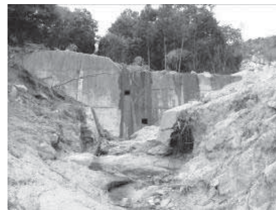
写真-2 被災した砂防堰堤
