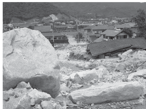
写真-7 石原地区の被害の状況
