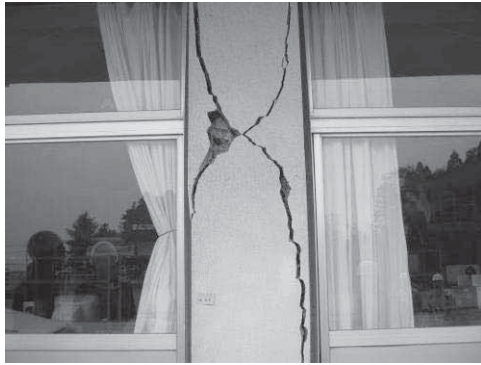
写真-2 1階Y0-X6柱(損傷度IV)
