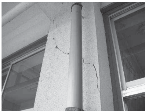
写真-3 1階Y0-X8柱(損傷度III)
