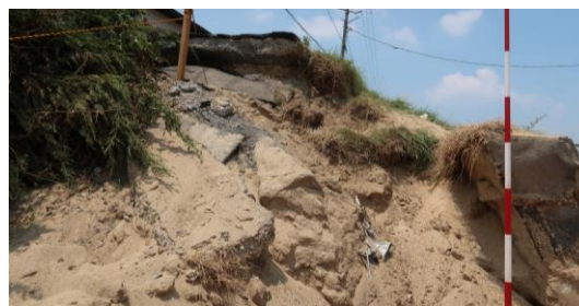
写真 1 露出した堤体における粗な砂質土
