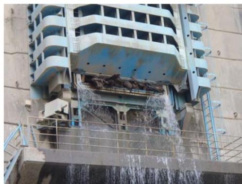
図1 閉塞した裾花ダムのコンジットゲート
