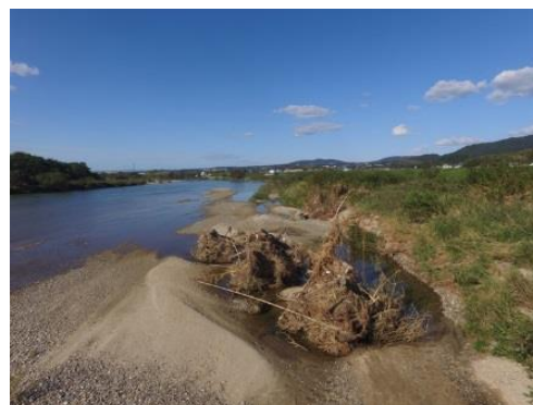
図 1 : 木津川 15.2k 砂州の中聖牛 (左 2017/12/7 水位:-2.65m 右 2018/10/8 水位:-2.05m)
