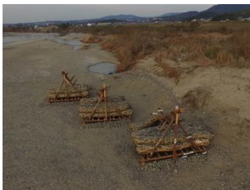
図 1 : 木津川 15.2k 砂州の中聖牛 (左 2017/12/7 水位:-2.65m 右 2018/10/8 水位:-2.05m)
