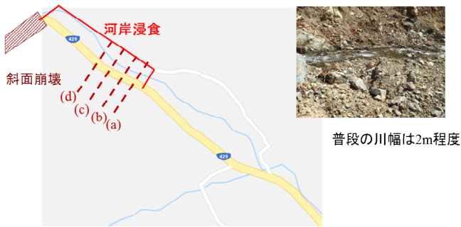
図-4 宍粟市高野川上流の斜面崩壊と河岸浸食
