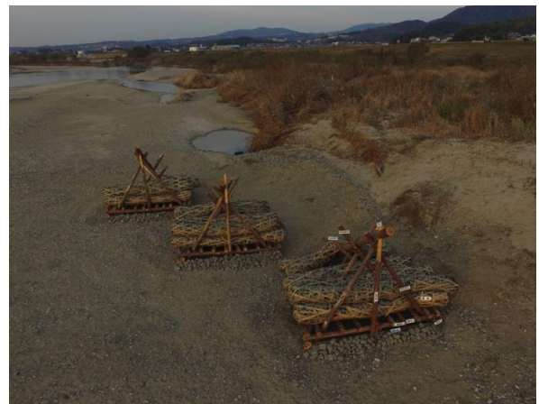
図1：木津川に試験施工された中聖牛3基
