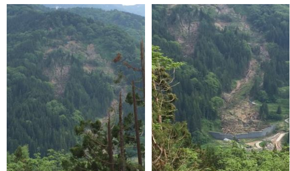
図-2 対岸から撮影した現地写真 (左：源頭部 右：砂防堰堤付近)
