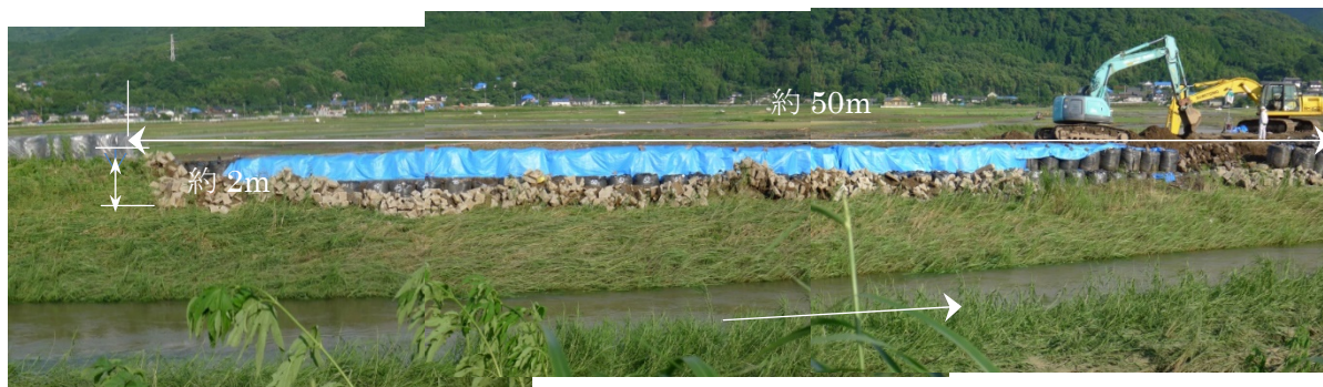
図-14 木山川左岸破堤の復旧 (6 月 23 日 17 時)
