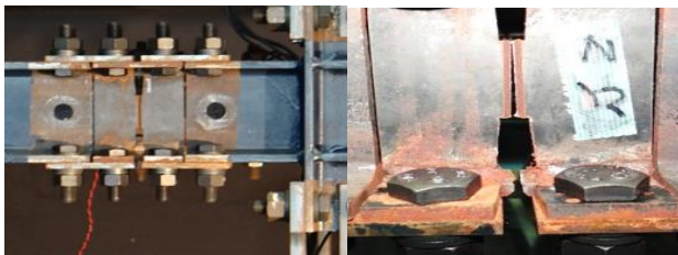
(b) 梁端リンクの損傷
