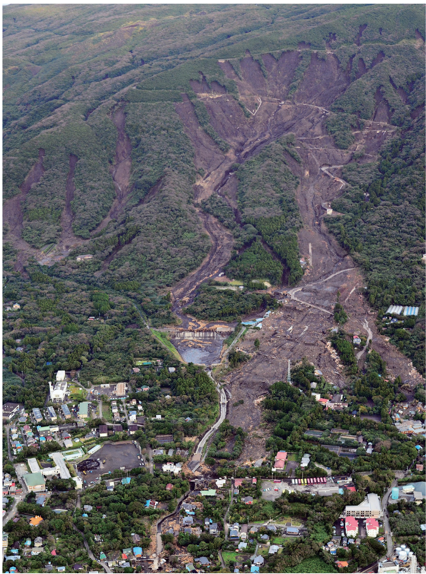
台風26号による伊豆大島における土砂災害〈写真提供／株式会社パスコ・セコム株式会社〉
