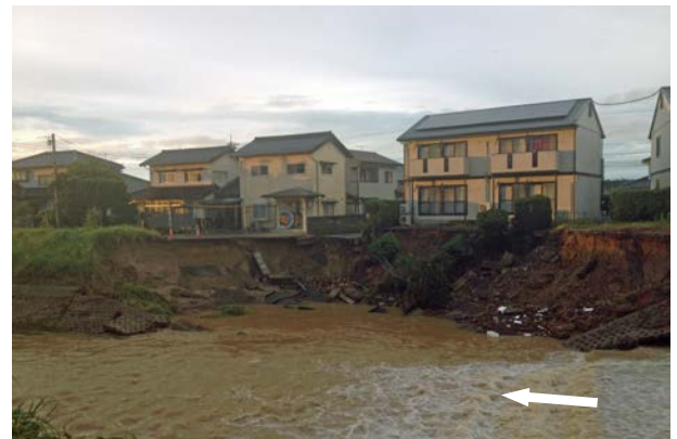
図 2 水尻川における側岸浸食 (江津市都野津町)
