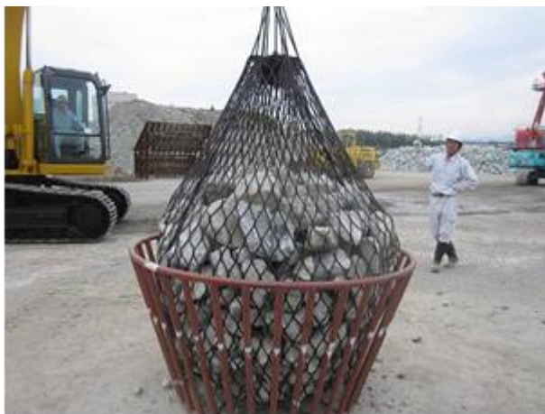
写真-1 製作中の網式消波ユニット
