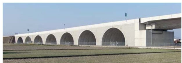
写真1 多ユニットアーチカルバート盛土
