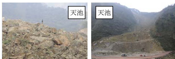
図-1 粒度偏析による形成した天然ダムの堤体
