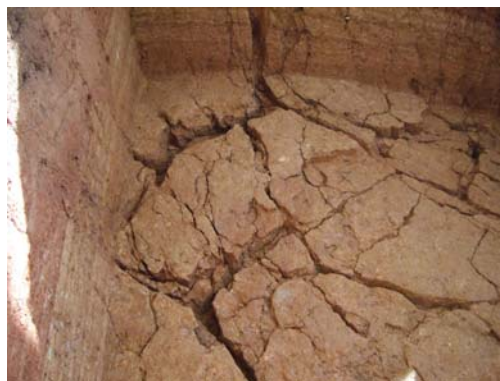
写真-1 墳丘内部に存在する地震による地割れ
