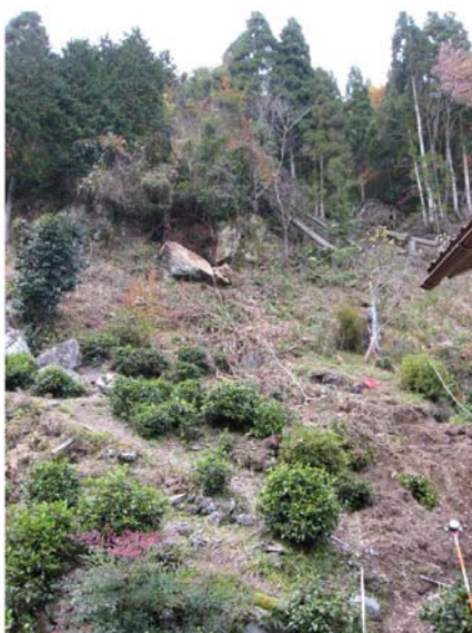
落石が起きた斜面の様子
