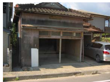
図1 虎居地区(1階部分がほぼ浸水し、1ヶ月が経過しても家財道具等が入れられない状態の家屋)
