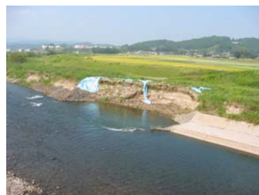
図2 河川堤防の被災(堤防の堤外側が崩壊している)
