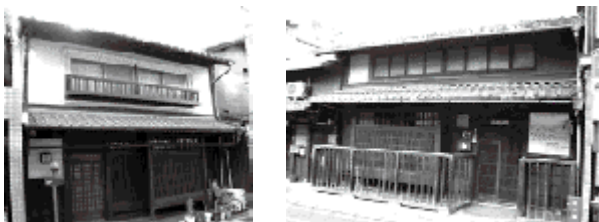
写真1 対象建物(左:2階建て、右:中2階建て)
