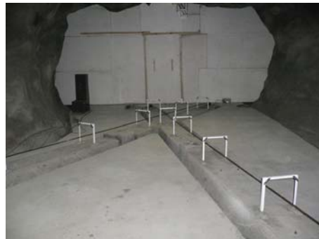
Fig.1 セット中の3成分伸縮計の一部
