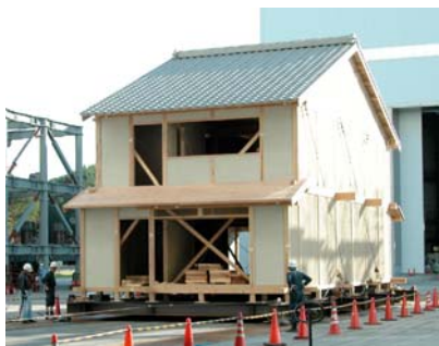
図-1 新築試験体
