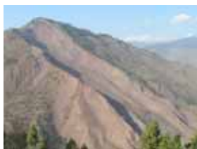
図3 Chakarの斜面崩壊
