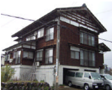
図1 対象建物の一例
