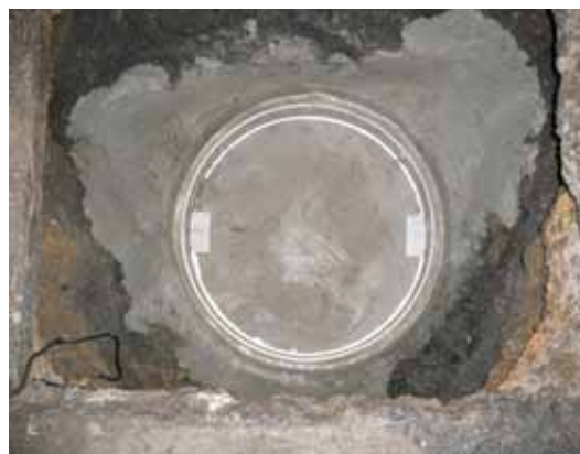
図 2：ひずみ計の設置
