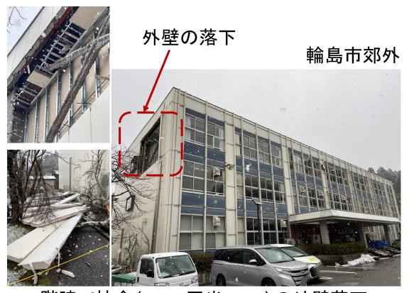
3階建て校舎(3,347平米, S56)の外壁落下
