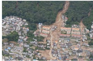
③土砂災害の状況 (広島県広島市)
