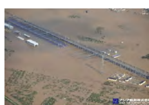
⑨北陸新幹線車両基地 (長野県長野市)
