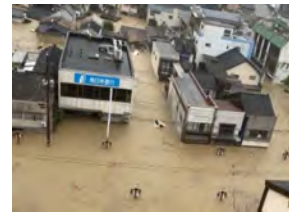
⑩球磨川における浸水被害 (熊本県人吉市)
