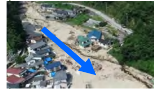
平成30年7月豪雨に伴う天地川(広島県坂町)の土砂・洪水氾濫発生状況
