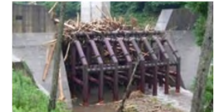
例: 透過型砂防堰堤による流木の捕捉
